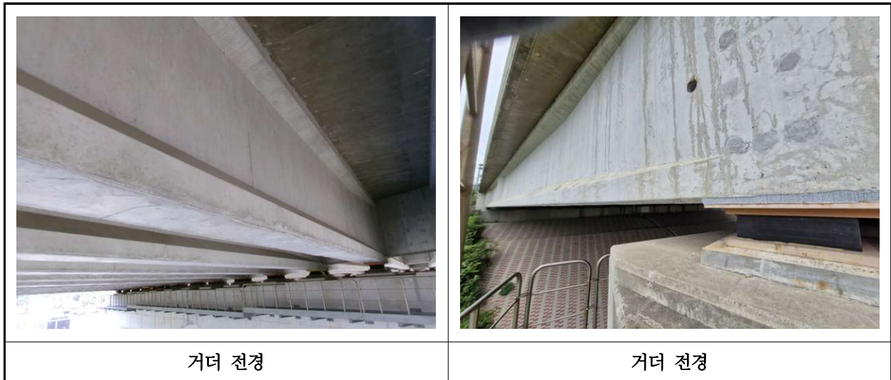
【사진 30.3.4】 거더 전경
