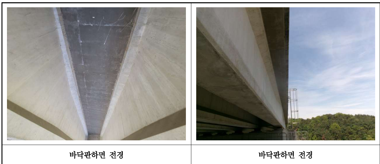
【사진 30.3.2】 바닥판하면 전경
