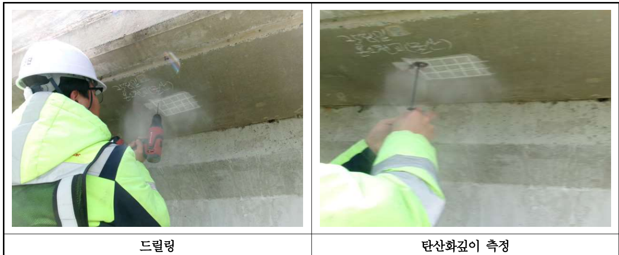
【사진 30.4.3】 탄산화 깊이 측정 현장사진
