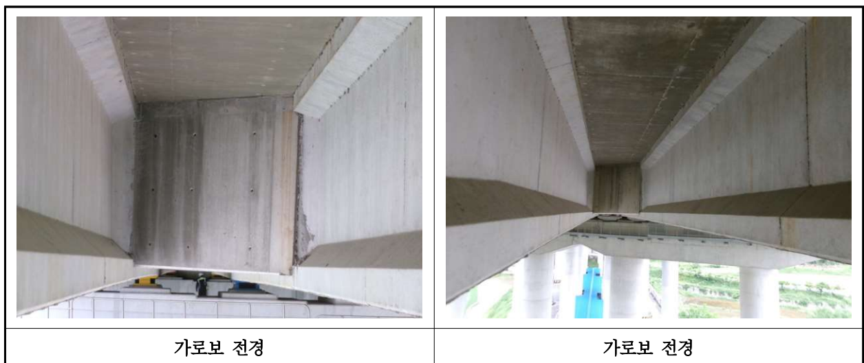
【사진 30.3.6】 가로보 전경
