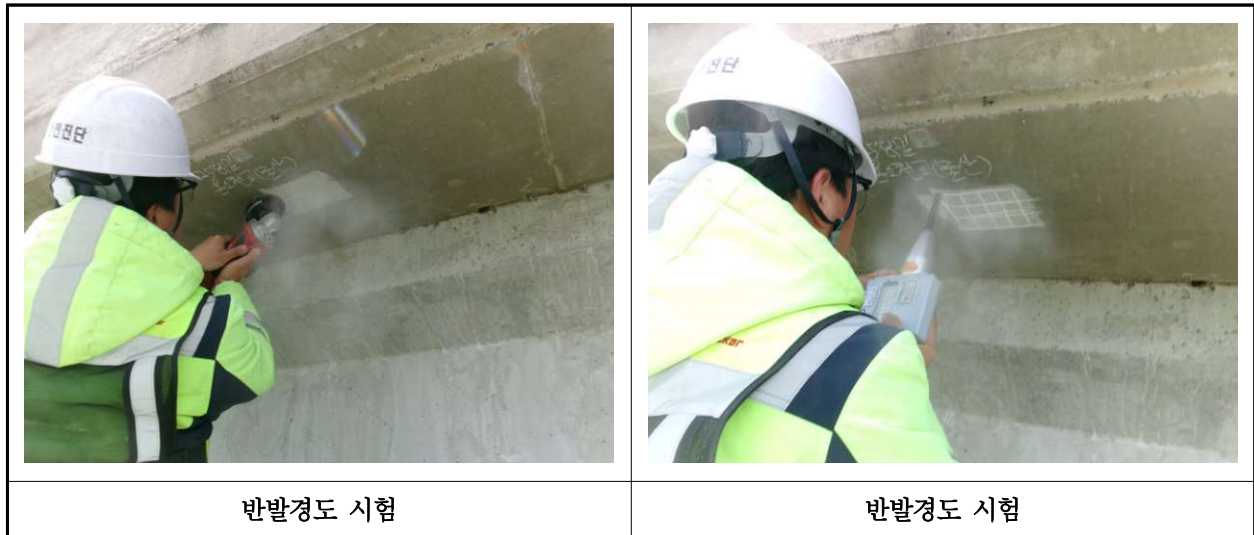
【사진 30.4.2】 반발경도시험 현장사진
