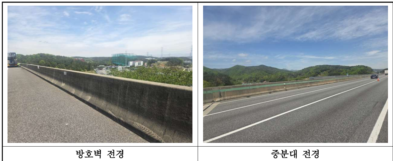
【사진 30.3.24】 방호벽 및 중분대 전경
