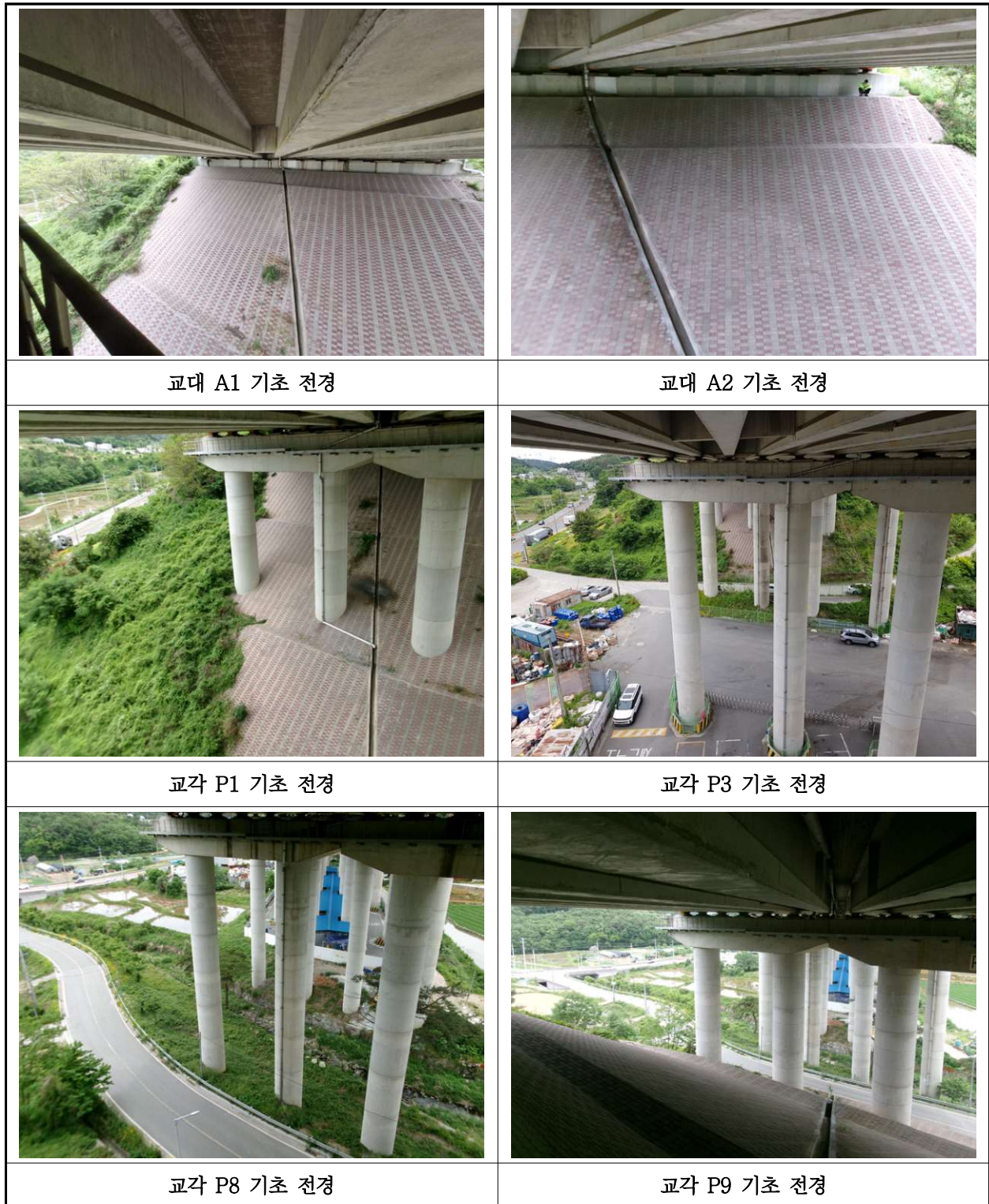
【사진 30.3.12】 기초 전경
