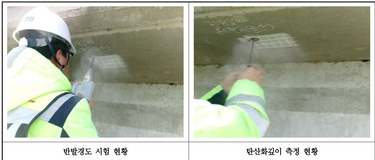
【사진 30.4.1】 콘크리트 내구성조사 현황
