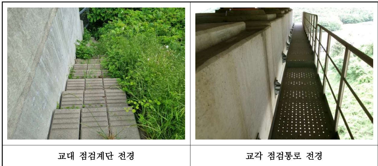
【사진 30.3.26】 교량 점검시설 전경
