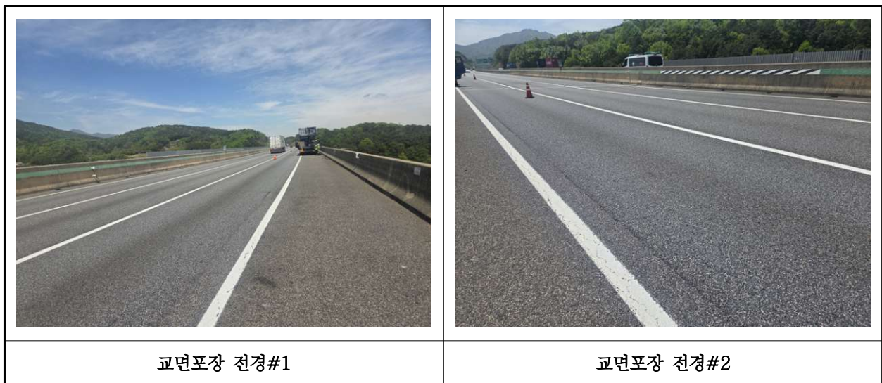
【사진 30.3.20】 교면포장 전경
