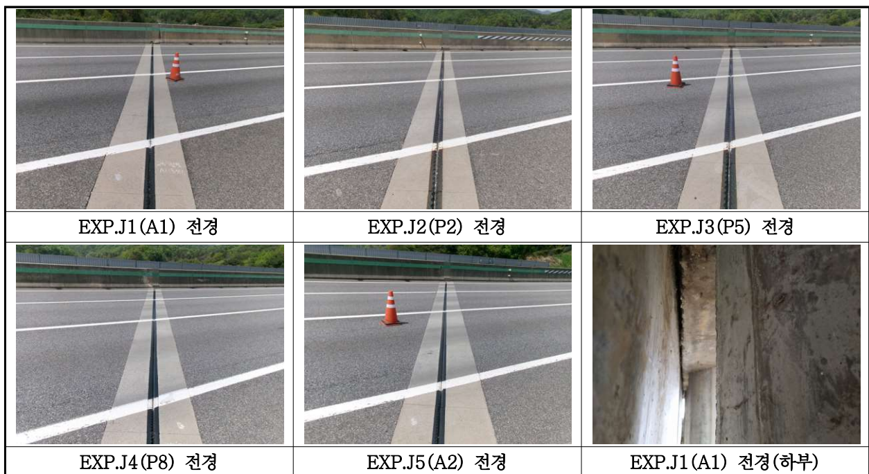
【사진 30.3.17】 신축이음장치 전경
